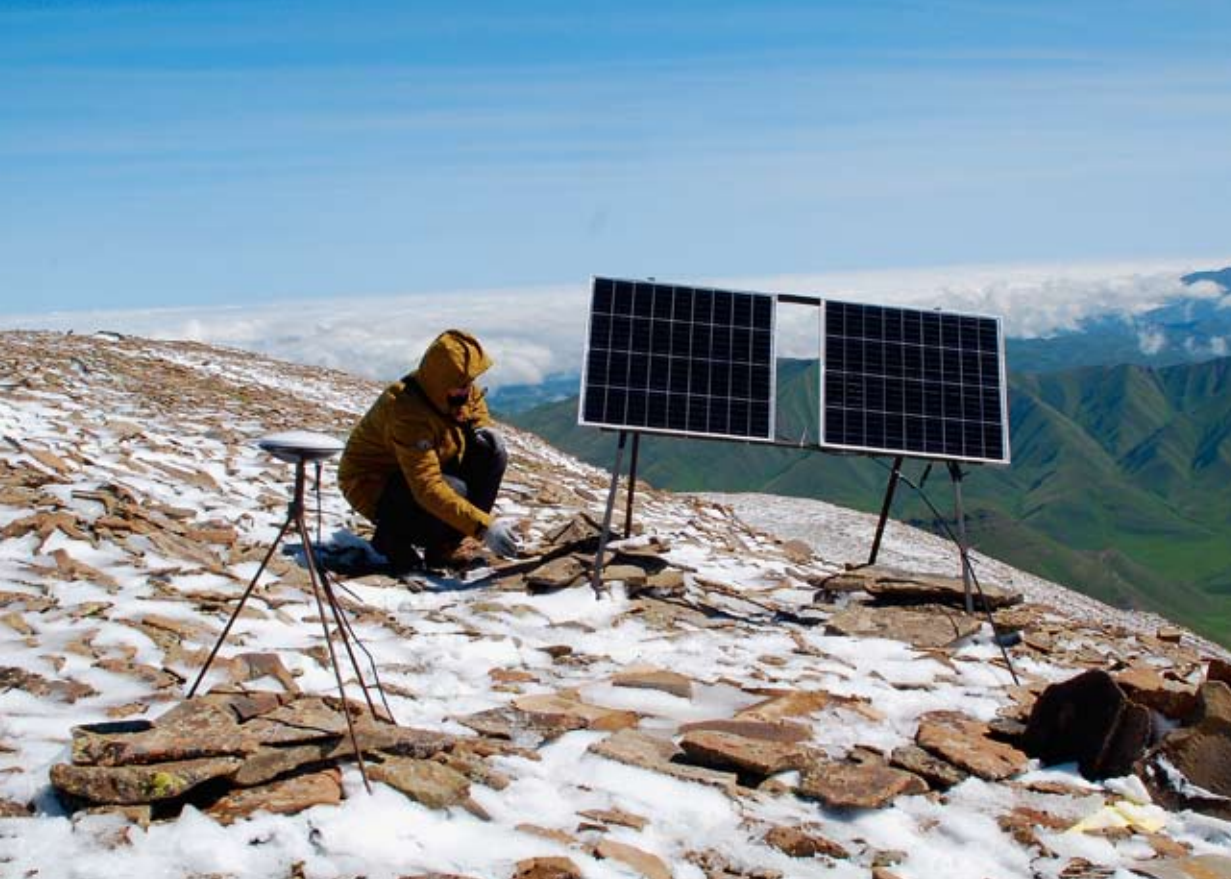
Монтаж системы автономного питания для работы ГНСС-станции и вышки метеостанции на горе Курапдаг (3600 м) в Агульском районе Республики Дагестан.
